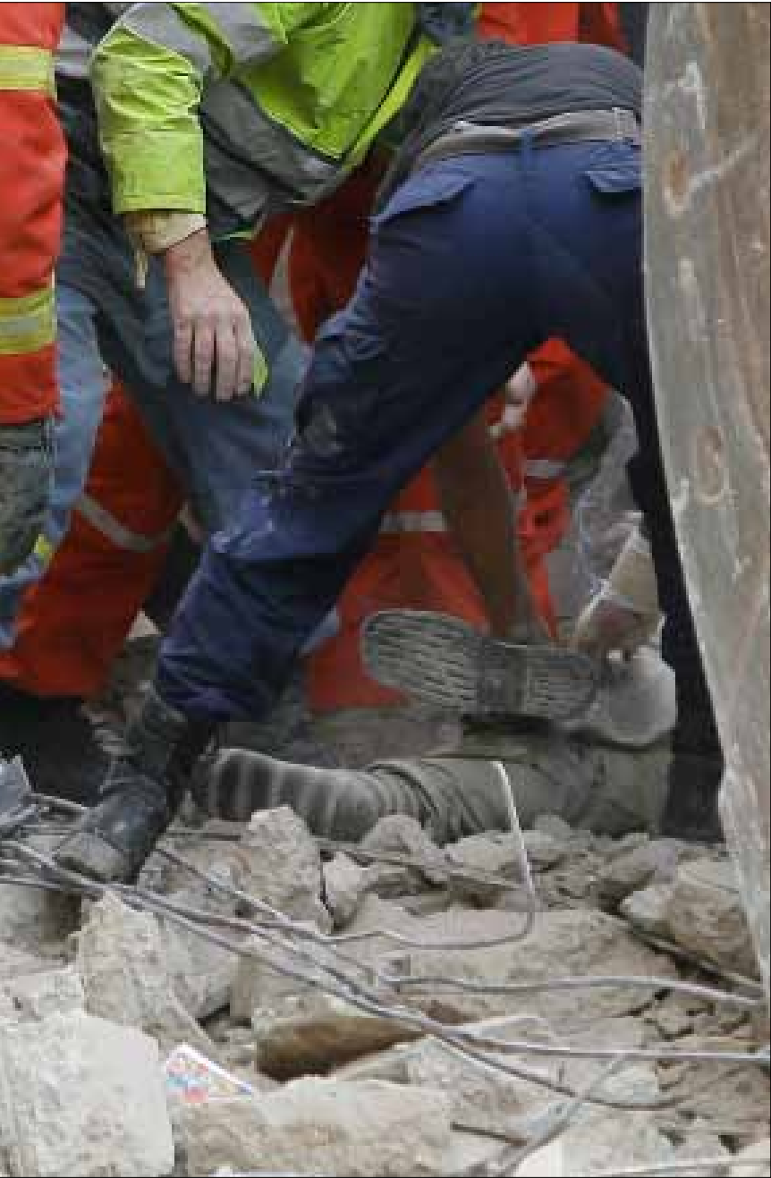
3 أسباب لانهيار المبنى: إهمال الصيانة، الحفريات وغياب التدعيم (مروان طحطح)
