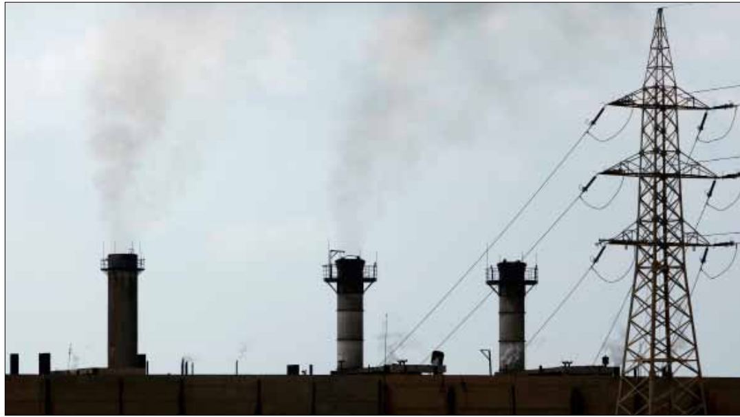
الكابل المعطل أساسي لتغذية مناطق عديدة بالكهرباء (أرشيف)
