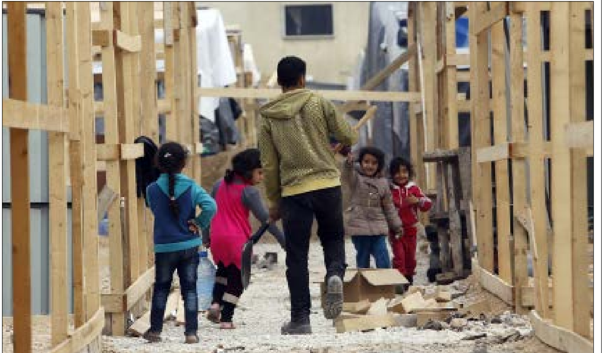
إعادة ترميم «مخيم الحماصنة» في بلدة غزة البقاعية (مروان طحطم)
